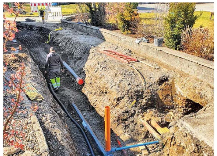
Neue Wasserleitungen für die Haushalte im Salzacker
